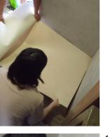
8. 壁とクッションフロアの隙間を コーキング材で埋める。
